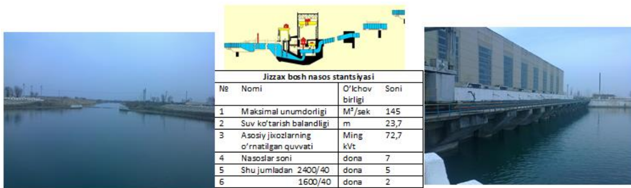
7.3.1-rasm. Jizzax bosh nasos stansiyasining ko'rinishi va asosiy jihozlari.
