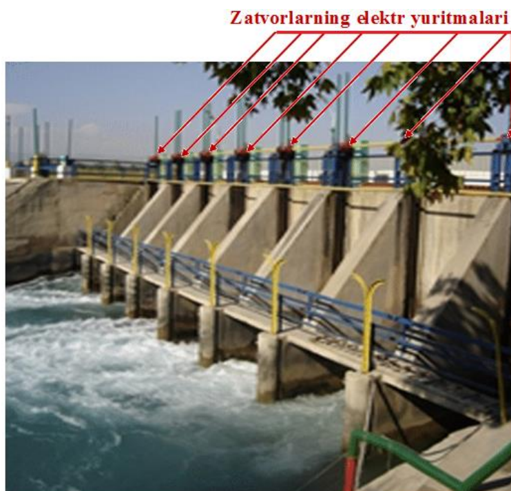
7.4.2-rasm. Elektr yuritmalali zatvorlar
